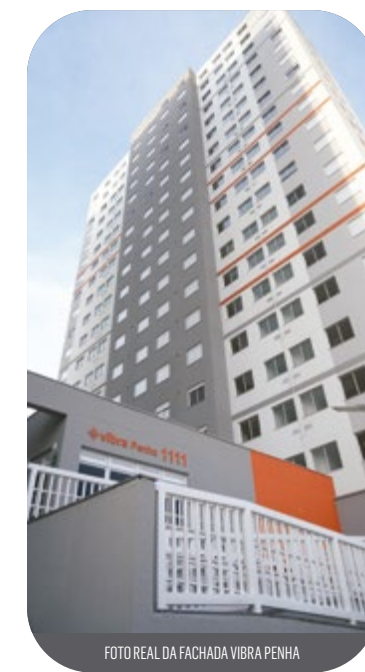
FOTO REAL DA FACHADA VIBRA PENHA
